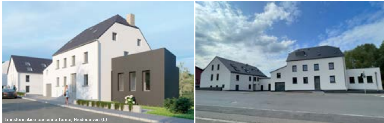
Transformation ancienne ferme, Niederanven (L)
