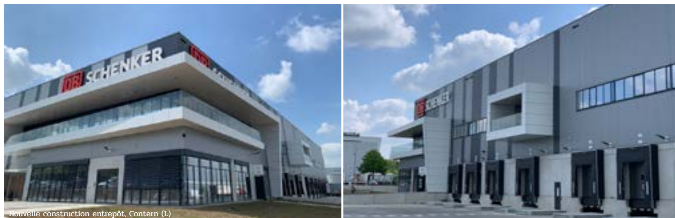
Nouvelle construction entrepôt, Contern (L)
