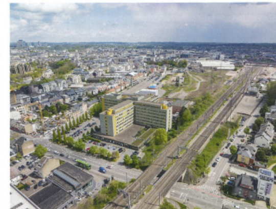
Vue aérienne du site, avant la démolition des bâtiments existants.
